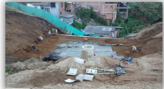
Muro en tierra armada capa 1
