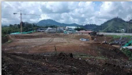
Campamento de obra
