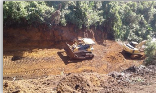
Adecuación de terreno para colocación de tubería de 42" en quebrada Montebonito.
